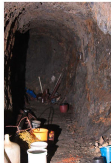
Innenansicht des hinteren Teils des Stollens. (Bild: Vorläufer-Germer).
